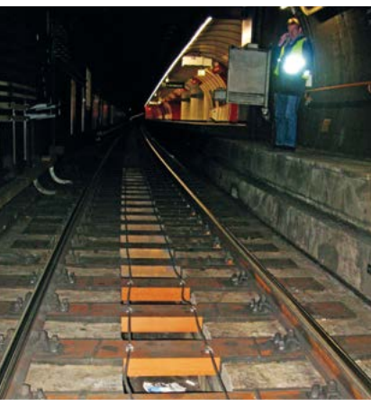
Austria | Wiener Linien | Fijación directa a un puente sobre el Danubio, en Viena
