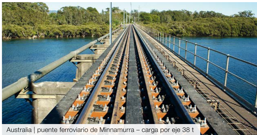
Base especial de madera sintética FFU sobre estructura portante de acero
